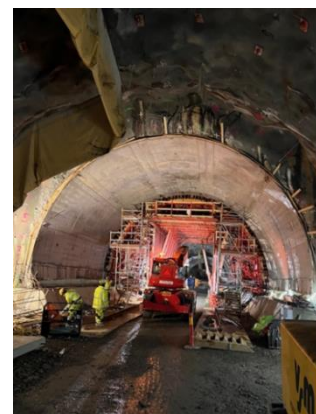
Mälarpassagen, gjutning av avjämningsbetong
